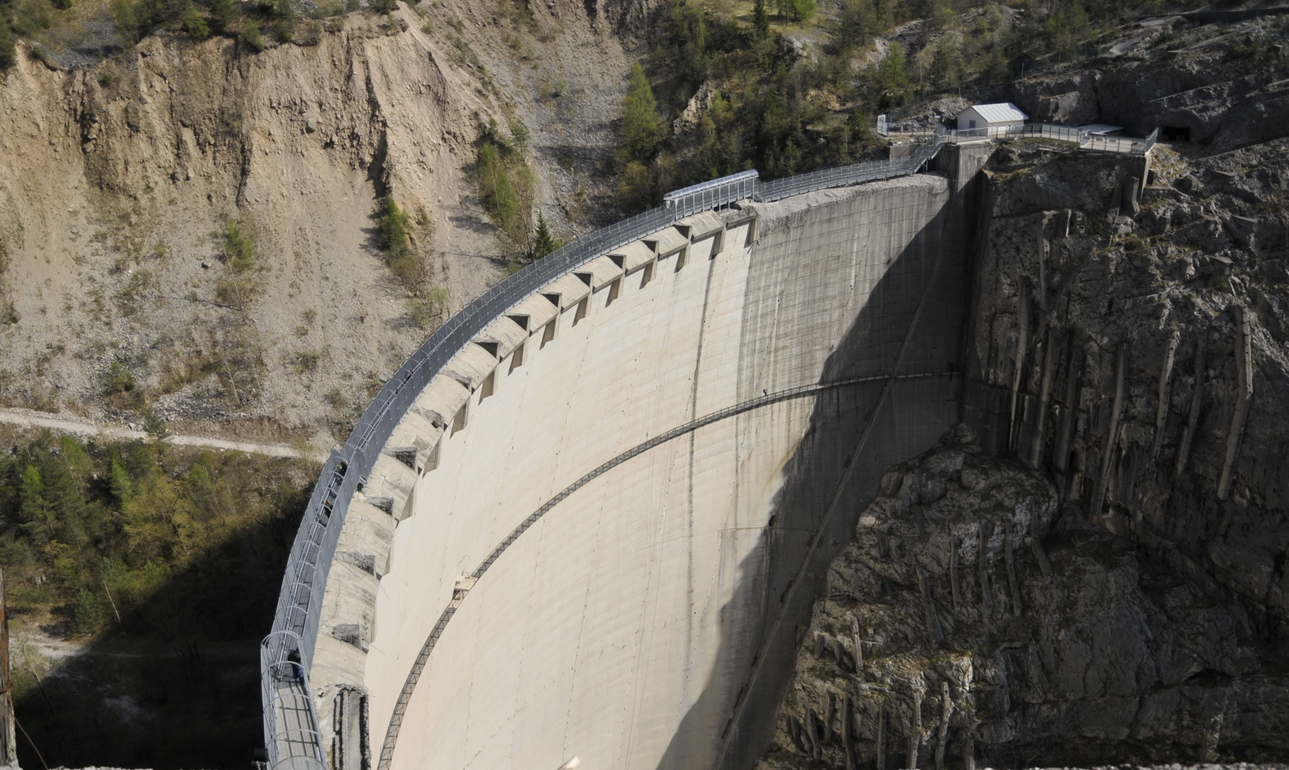
La parte sommitale con il coronamento della diga. Il sentiero presente è stato tracciato per raggiungere la base della porzione di diga che emerge per soli 60 metri dal riempimento
